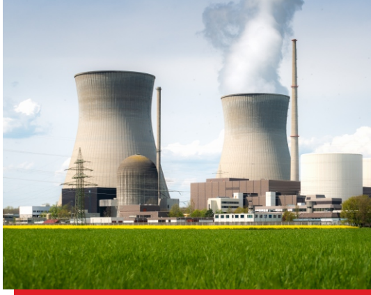
NHÀ MÁY ĐIỆN
